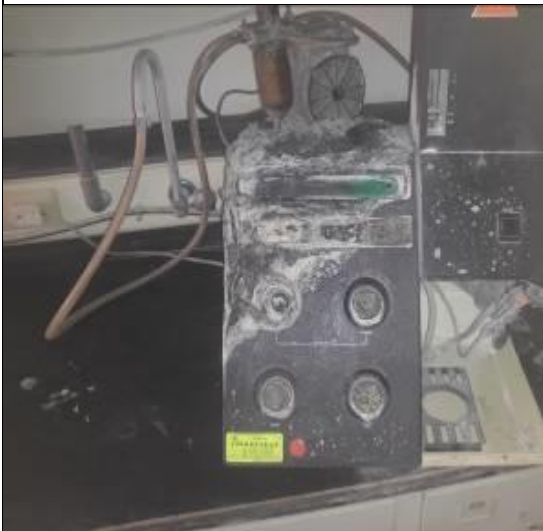
圖 1.經鑑識疑似起火點(此點為瓦斯管脫落可能氣體洩漏點)
